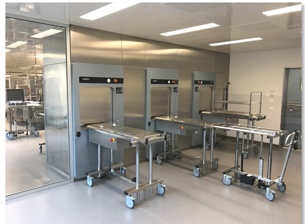
Neue ZSVA in Kanton AG: RGD & Sterilisatoren
