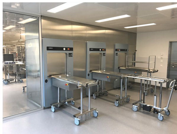
Nouveau CSSD dans le canton AG : appareils de lavage et désinfection & stérilisateurs
