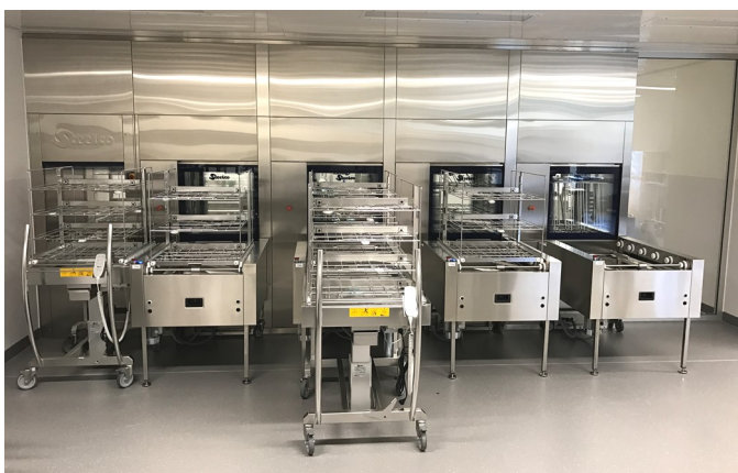
Nouveau CSSD dans le canton AG : appareils de lavage et désinfection & stérilisateurs
